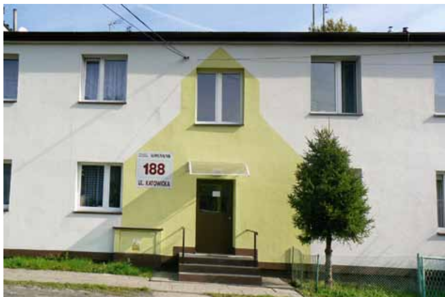
ul. Katowicka 188 w Chorzowie
